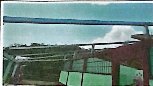
Foto 2: Imagen que muestra el corredor con estructura.
