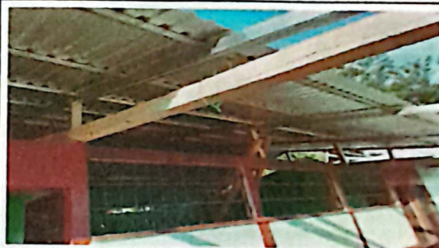
Foto 4: Imagen que muestra el entechado de las 3 aulas.
