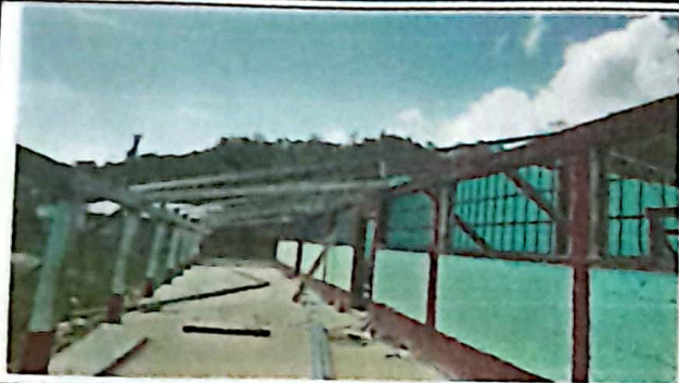
Foto 1: Imagen que muestra la colocación de la estructura.
